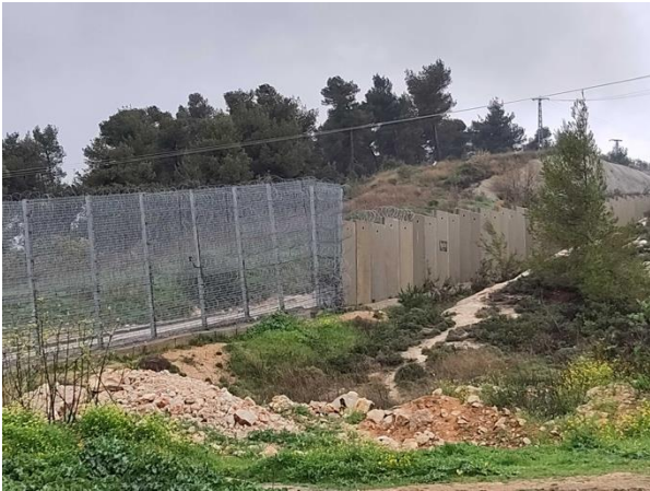
Übergang Stacheldrahtzaun zu Trennmauer in Al-Walajah
